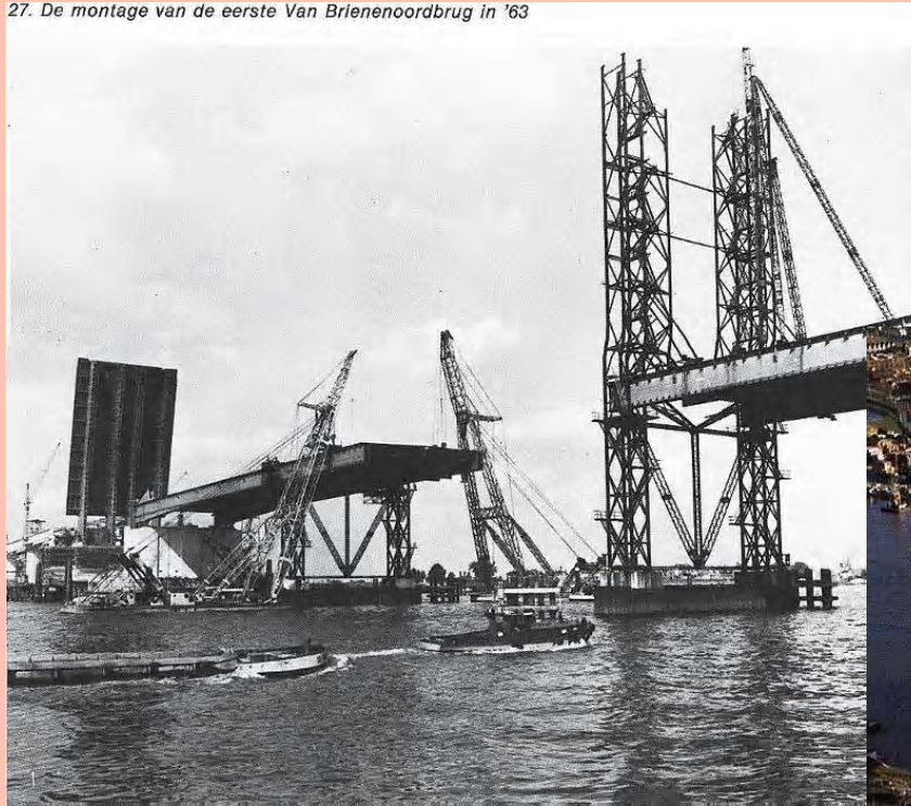
27. De montage van de eerste Van Brienenoordbrug in '63
