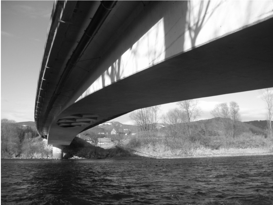
Bild 1: Murbrücke St. Lorenzen
