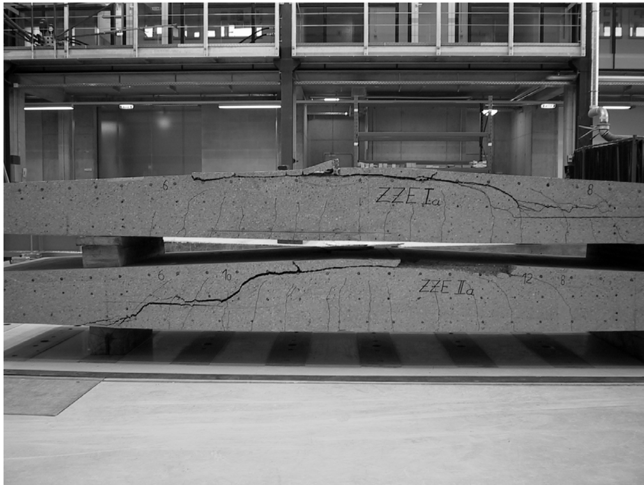
Riss setzt sich beidseits im monolithischen Beton fort
