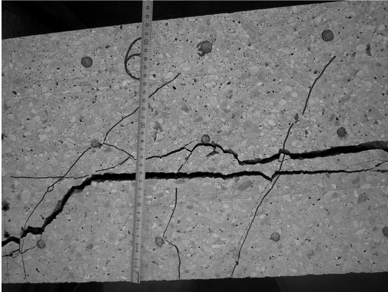
Detail: Riss auch parallel zur Schubfuge
