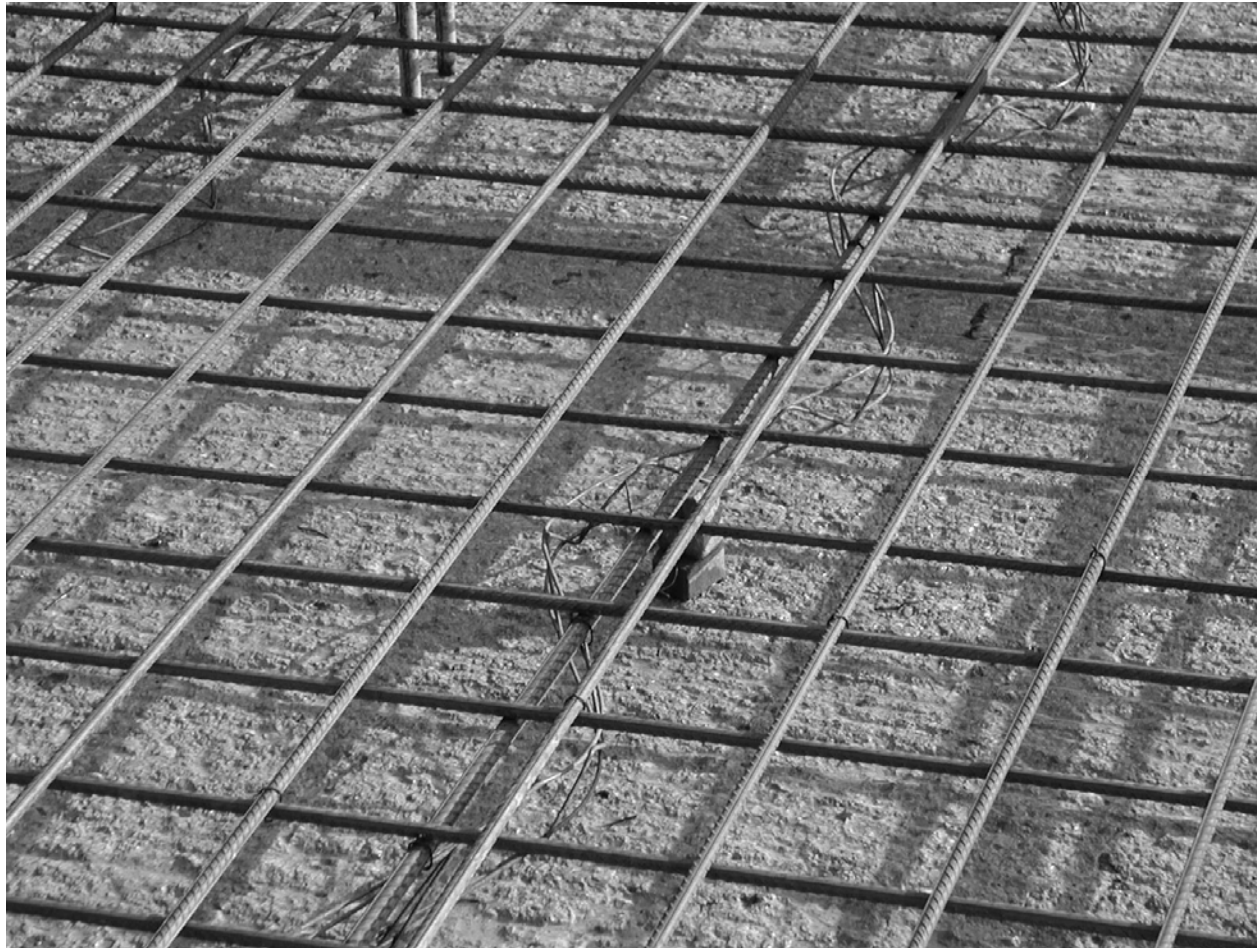
Oberfläche vor Ort
