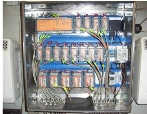
Bild 3: Schaltschrank im Hydraulikraum mit Steuereinheit, Messverstärkern und Modem
