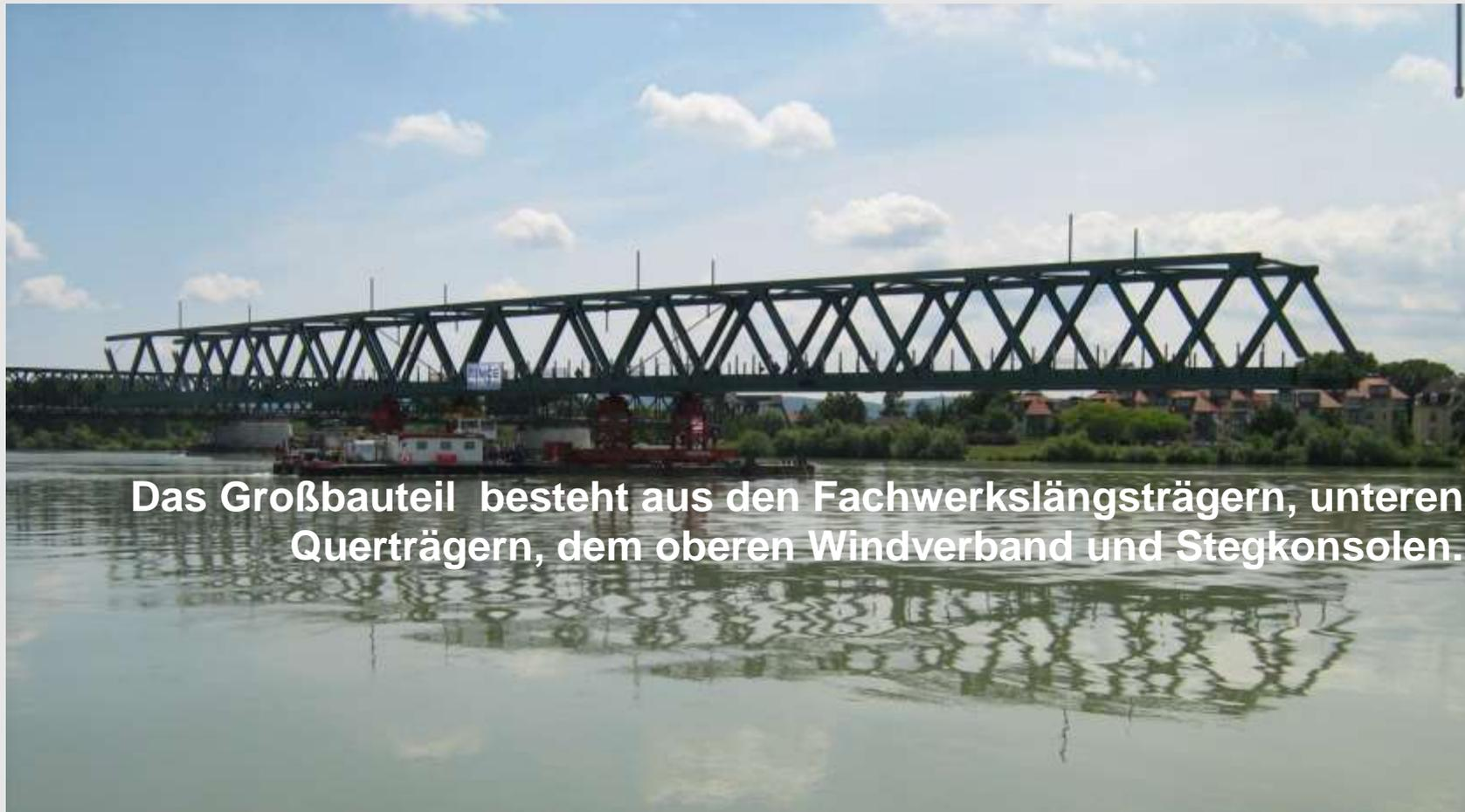
**Das Großbauteil besteht aus den Fachwerkslängsträgern, unteren Querträgern, dem oberen Windverband und Stegkonsolen.**
