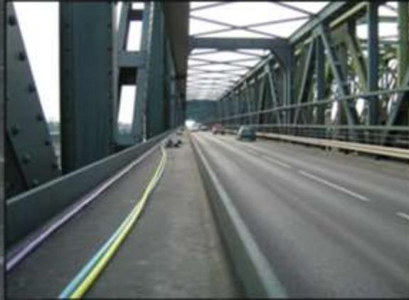
Die Leitungen wurden durch vorhandene Öffnungen im Tragwerk durchgeführt . Oberhalb der Straßenbrücke wurden diese im U-Profil (Anfahrtschutz für das Tragwerk) untergebracht.
