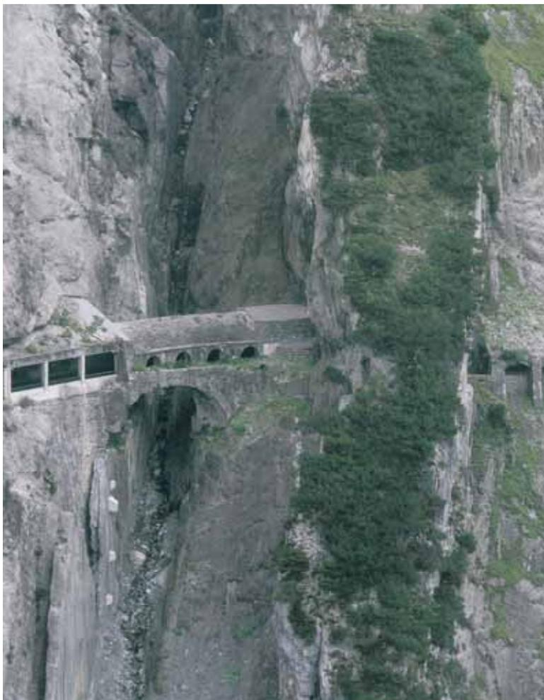
Das Hölltobel ist eine Felsschlucht und befindet sich ca in der Mitte der Flexengalerie auf 1600 m ü A. Es wird flankiert von über 100 m hohen Felswänden. Das Hölltobel wird mittels einer Brücke (BJ 1938 u. 1955) mit aufliegendem Galeriegewölbe (BJ 1955) überspannt. Vor und nach dem Hölltobel verläuft die L198 in eine Galerie (BJ 1982) und in einen Tunnel BJ 1955). Im Sommer besteht Steinschlag- und im Winter Lawinengefahr. Das Hölltobel wird als das Herzstück der Flexengalerie bezeichnet.
