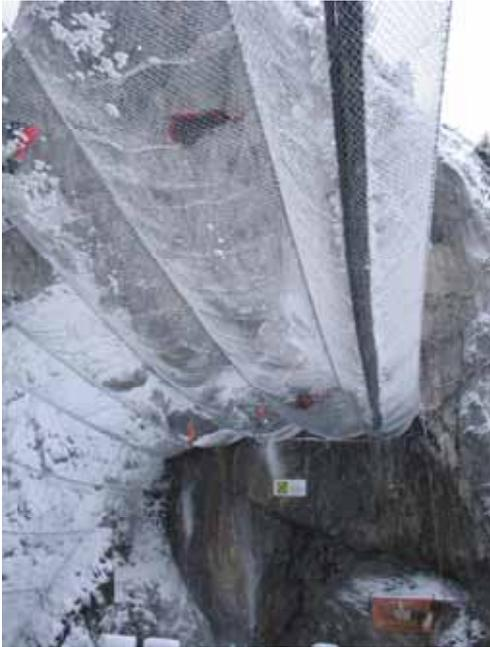
Vor Angriff der Bauarbeiten musste zuerst zum Schutz des allgemeinen Verkehrs und der Arbeiter ein temporäres Steinschlagschutznetz ca 10 m über dem neuen künftigen Galeriedach hergestellt werden. Die Bemessung erfolgte für eine Steingröße von  $1/8 \text{ m}^3$  aus einer freien Fallhöhe von 10 m.
