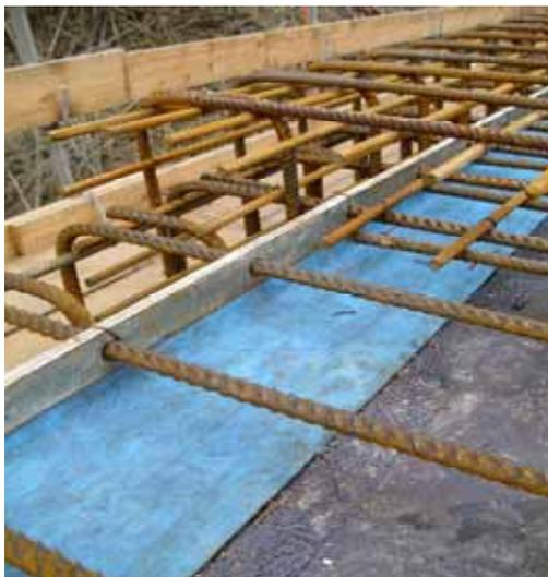
Das Land Salzburg hat die Lizenz für dieses patentrechtlich geschützte Verankerungssystem erworben und bei Brückenverstärkungen und Brückenneubauten bereits über 700 Laufmeter Gesimse mit diesem System ausgeführt bzw. verankert. Das System hat sich bestens bewährt. Die bauausführenden Firmen und insbesondere Isolierfirmen haben sich sehr positiv über dieses neue Verankerungssystem geäußert.
