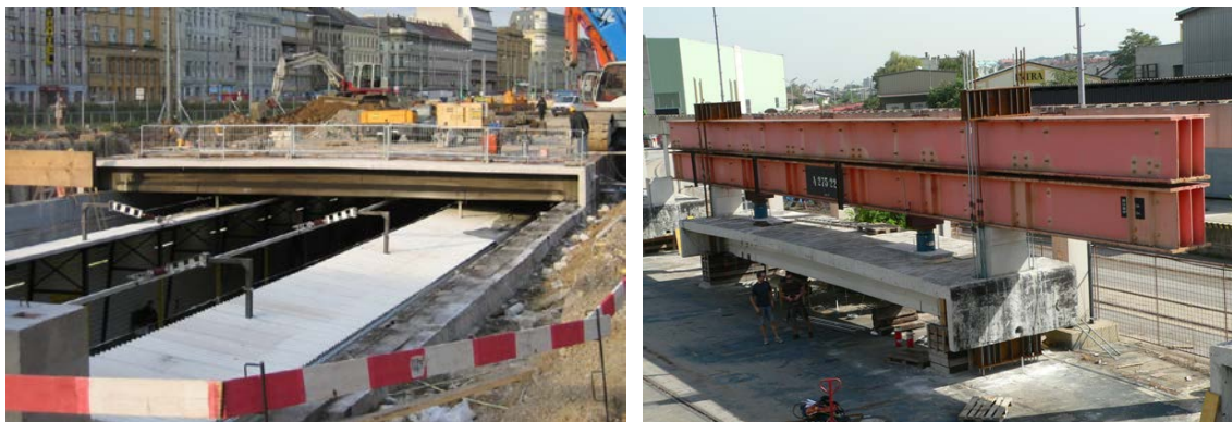
Abbildung 2, links: Aushubvorgang, rechts: Versuchsaufbau
