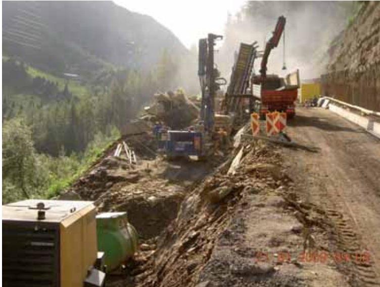
Bild 6: talseitige Fundamentherstellung
