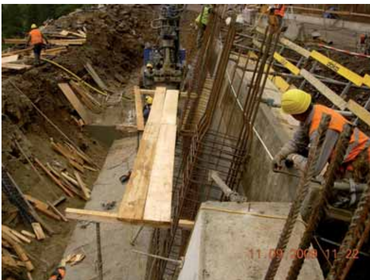
Bild 4: Fundamentvorlauf Talseite
