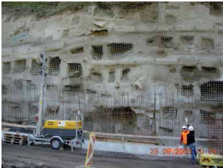
Bild 5: Spritzbetonnagelwand
