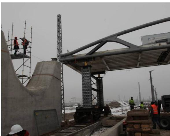
Die Tragwerksteile werden im Montagewerk vormontiert und nach der Grundbeschichtung auf die Baustelle geliefert, wo die Tragwerke am Boden zusammengebaut werden.
