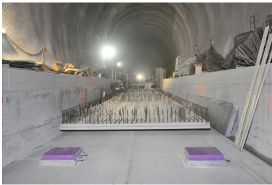
Bild 3a: Einzellager mit Halbfertigteilplatte
