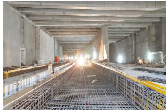
Bild 3b: Einbau Ortbetonbewehrung
