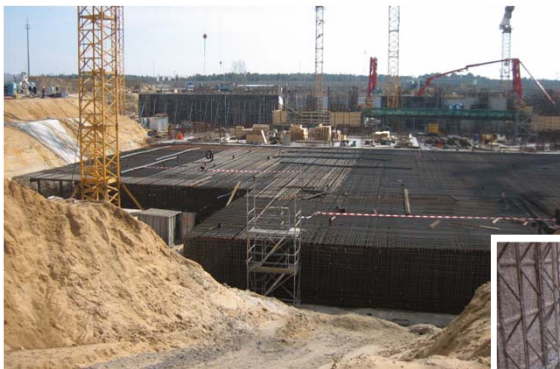
Bodenplatte Kraftwerk Boxberg
