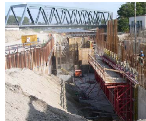
Bodenplatte und Kammerwand Schleuse Sülfeld
