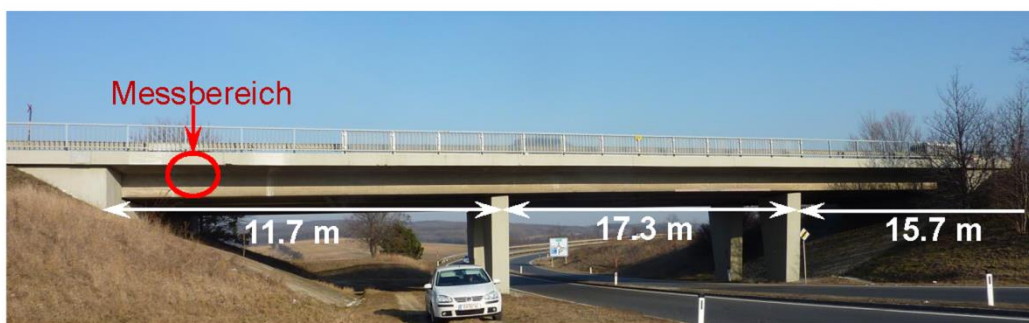
Abbildung 1: Ansicht der Plattenbalkenbrücke mit Markierung des Messbereichs.
