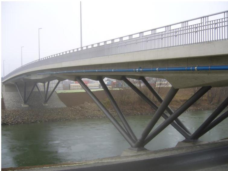
Dabei wurde das Konzept des flexiblen Widerlagers umgesetzt, welches durch eine Weicheinlage zwischen einem eigenstandfestem Erdkörper und Widerlager im Jahreszeitlichen Verlauf keine Beanspruchungen aus dem Erddruck in das Bauwerk einleiten soll.
