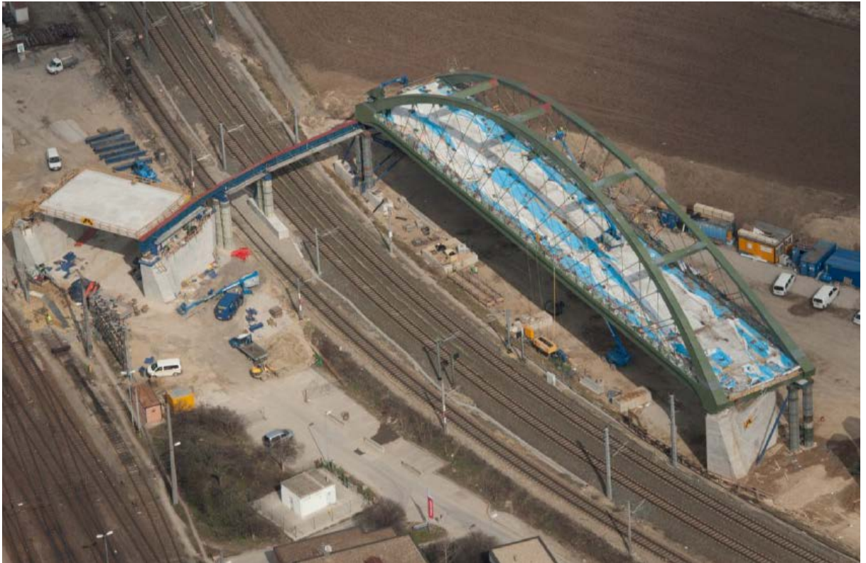
Montage des Tragwerkes TW5.3 parallel zu den Gleisen der Flughafenschnellbahn
