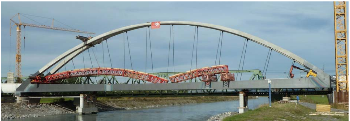
Fig 4 Rheinbrücke Rückbau Lehrgerüst
