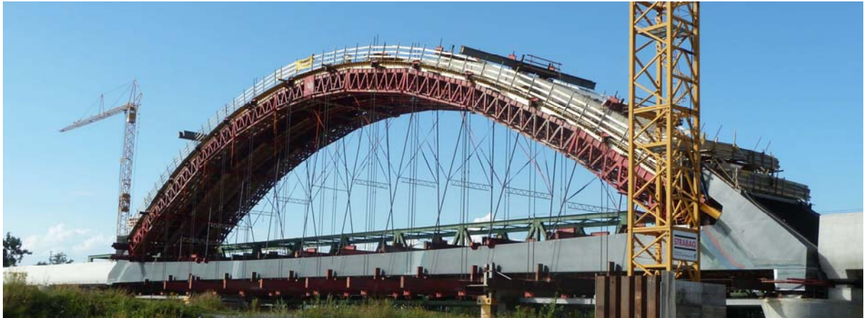
Fig 3 Rheinbrücke Lehrgerüst
