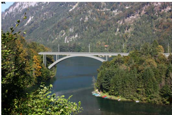
Bild 3: Bogenbrücke über die Steyr
