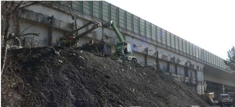
Abbildung 6 S6 Semmering Schnellstraße, Stützmaer Kaltbach
