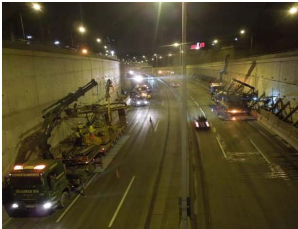
Abbildung 8 Permanente Sicherung mittels Stab- und Litzenanker
