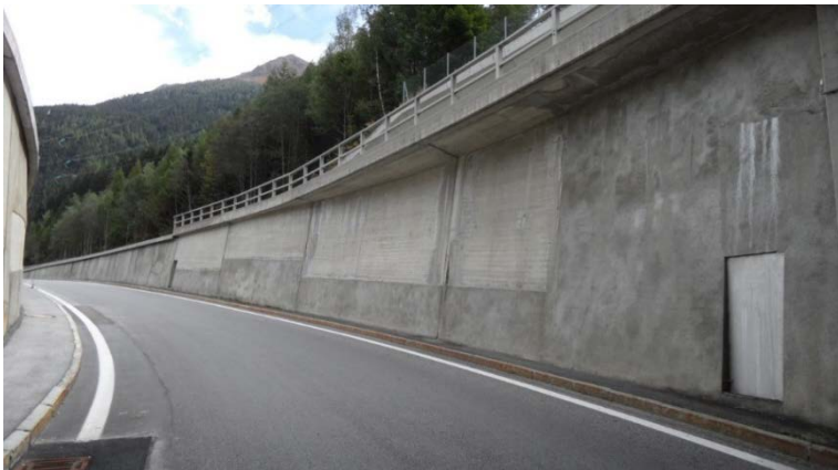
Abbildung 2 S16 Arlberg Schnellstraße, Stützmauer zwischen Spur 300 und Spur 400 der Anschlussstelle Pettneu
