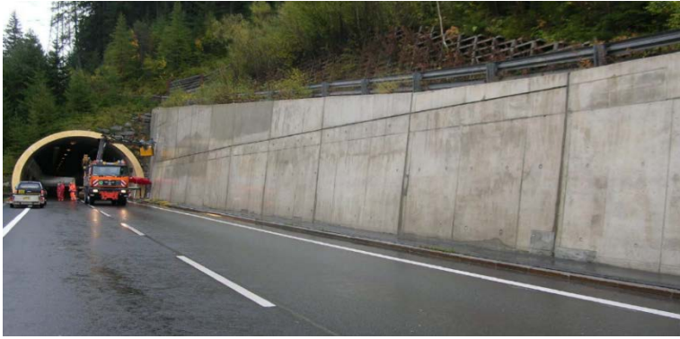
Abbildung 1 S16 Arlberg Schnellstraße, Stützmauer westlich des Pettneuer Tunnels
