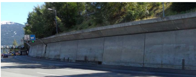
Abbildung 4 A13 Brenner Autobahn, Stützmauer Mautstelle Schönberg
