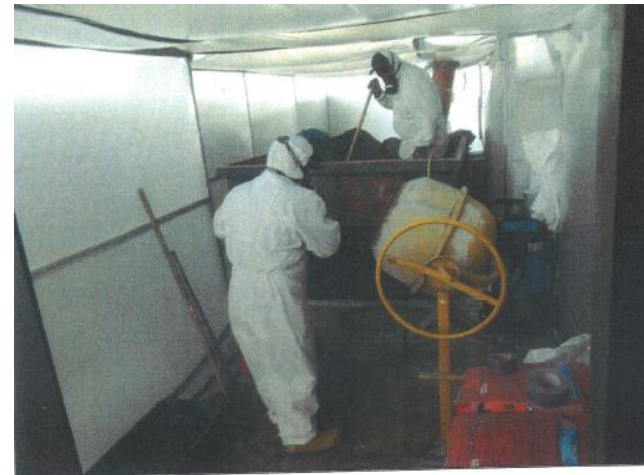
Abbildung 13: Verfestigen des kontaminierten Strahlsandes
