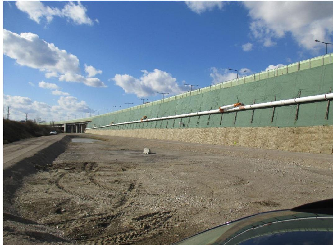
Bewehrte Erde Konstruktion mit Erosionsschutz und prov. Entwässerung der Bestandstragwerke
