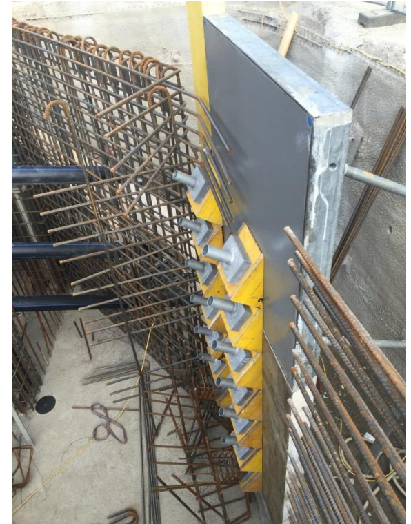
Rückseitige Verankerung der Stabspanglieder zur Einleitung der Tragseilkräfte in das Widerlager
