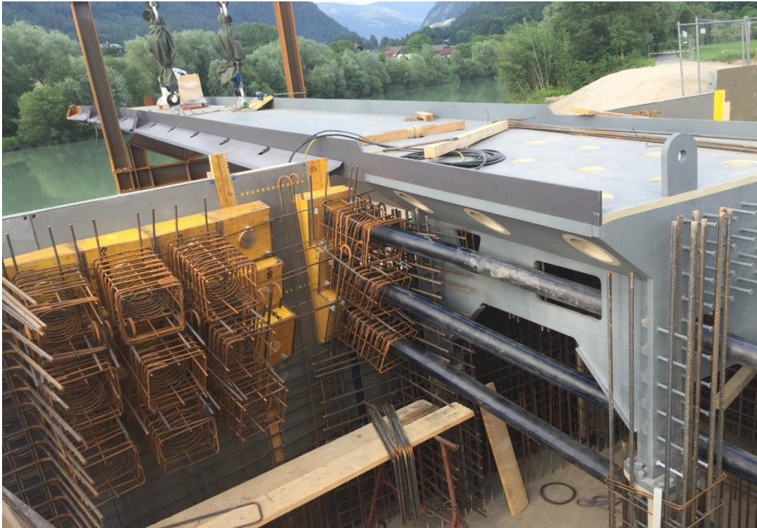
Stahleinbauteil Tragwerk mit einem ersten Teil der Leerverrohrung für die Freispielanker zur Ableitung der Horizontalkräfte aus dem Tragseil
