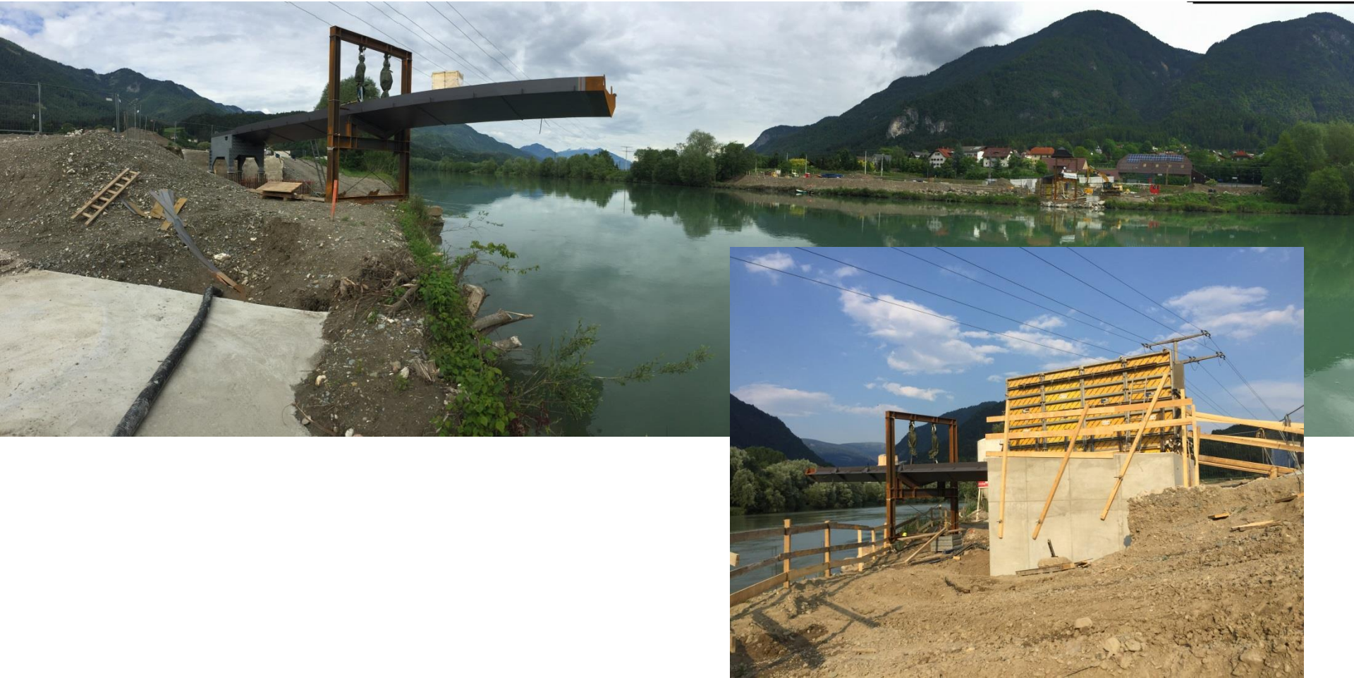
Stahleinbauteil WL Töplitsch mit höhenjustierbarer Hilfsunterstellung im Bauzustand
