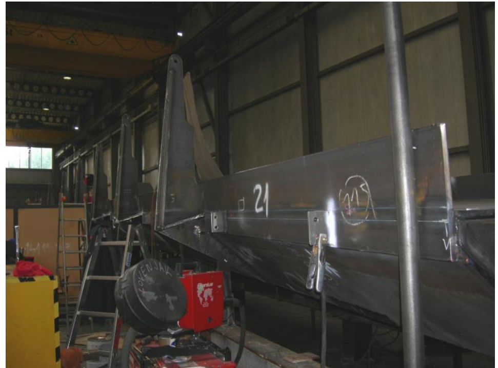
Stahltragwerk – Brückendeck Fertigung im Werk
