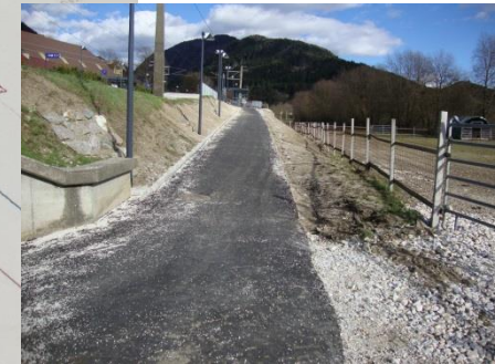
Auf-/Abgangsrampe Gleis Richtung Villach
