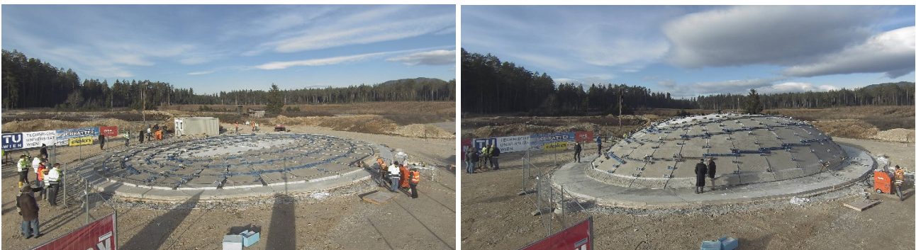
Abbildung 3: Ursprünglich ebene Platte (links) und fertiggestellte Betonschale (rechts) der Betonschale, die später als Veranstaltungsüberdachung genutzt werden soll © Webcam von Dipl.-Ing. Wolfgang Reinisch - http://reinisch.at/ im Auftrag ÖBB Infrastruktur
