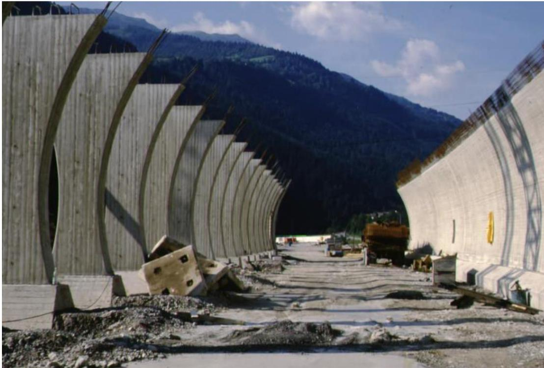
Abbildung 1: Errichtung der Galerie Fallender Bach - Zwischenbauzustand vor Betonage des Gewölbes
