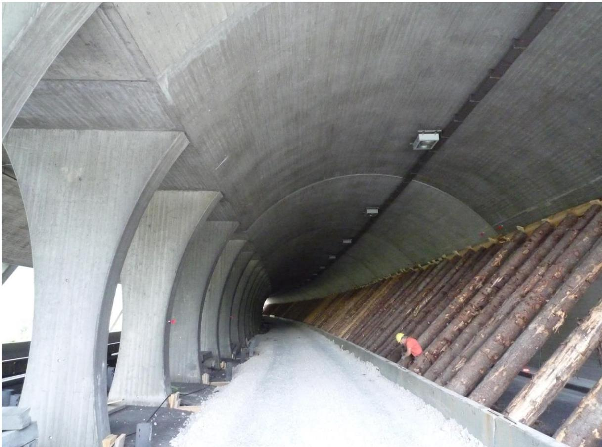
Abbildung 4: Abstützungen der geschädigten Tunnelschale mittels Rundhölzer als Sofortmaßnahme.
