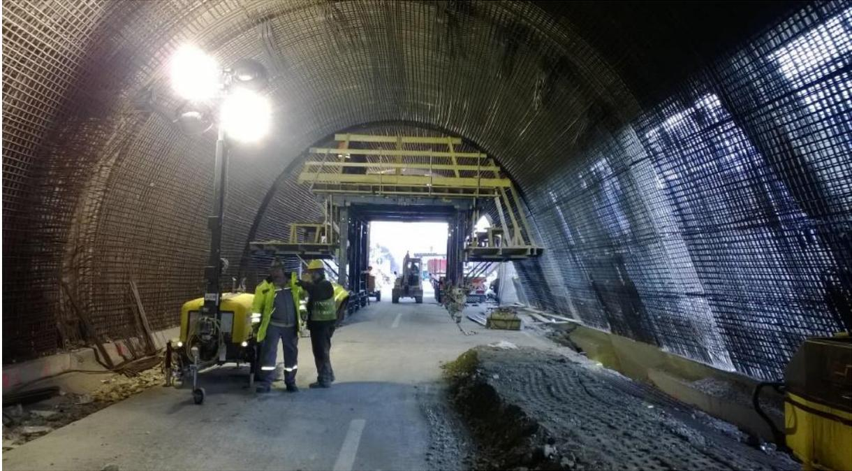
Abbildung 6: Bewehrung der Innenschale einschließlich Bewehrungsmontagewagen
