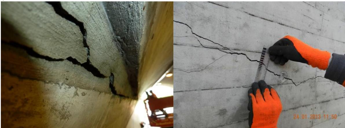
Abbildung 2: Risse mit großen Rissweiten und Rissversatz im bergseitigen oberen Bereich der Innenschale
