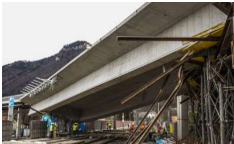
Abbildung 1: Einsturz Brücke Frohnleiten Februar 2015 (Quelle: Kleine Zeitung).
