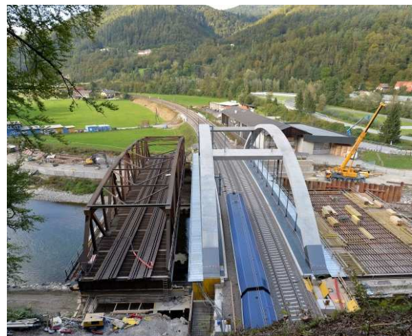
Baustellenansicht Wiederaufnahme Richtung des Norden nach Betriebes
