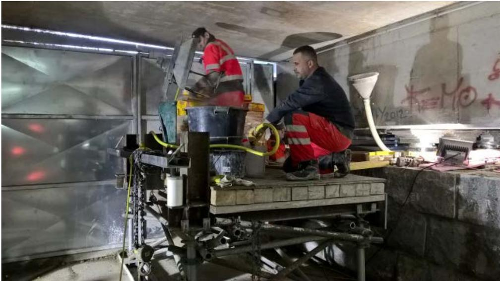
Absenkung des Tragwerkes nach Erhärtung des Vergussmörtels (Sikadur 316)
