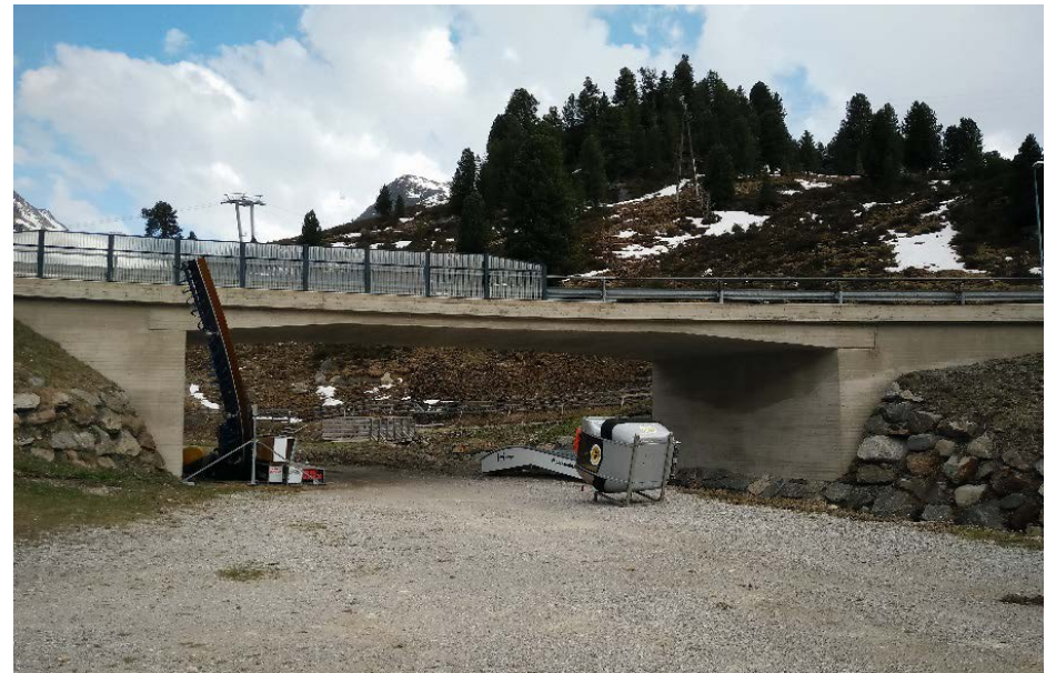
Rahmenbrücke im Kühtal 27.5.2016 L13-Finstertalbach
