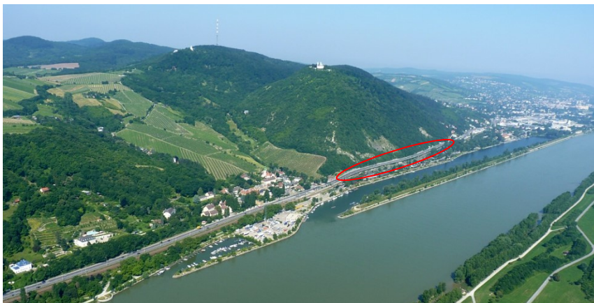
Blick auf das Objekt B1955 aus dem SO
