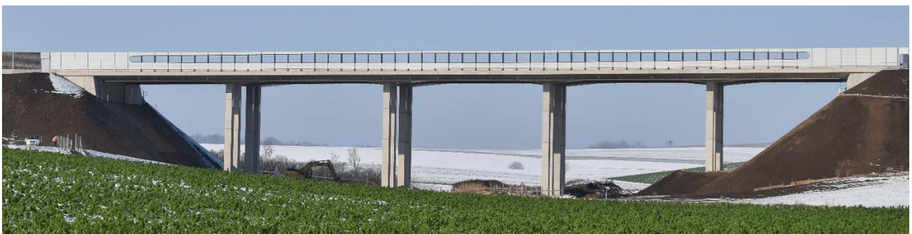
Bild 3 Satzengrabenbrücke kurz vor der Eröffnung im Dezember 2017, ©Eichwalder
