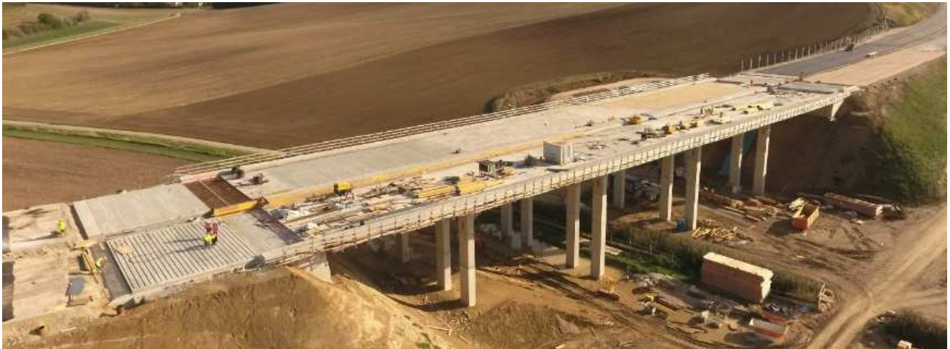
Bild 2 Einbau der Fahrbahnübergangskonstruktionen an den jeweiligen Brückendenen, ©Asfinag
