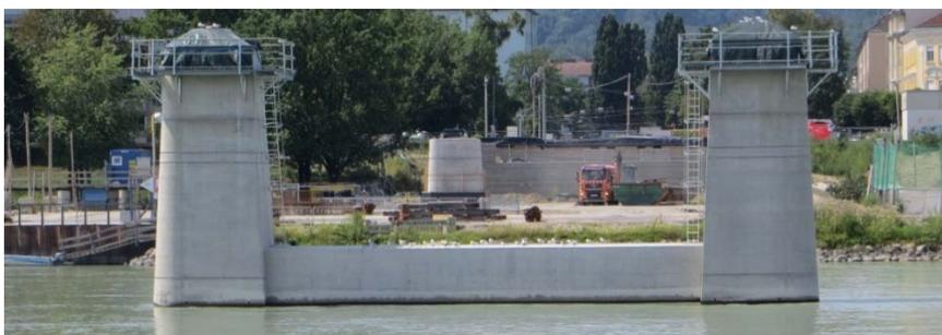
Oberhalb der Wasserlinie sind nur die zentral im Bogenscheitel angeordneten „Tragsockel“ und eine Verbindungsscheibe, welche bei Hochwasser überströmt wird, zu sehen.
