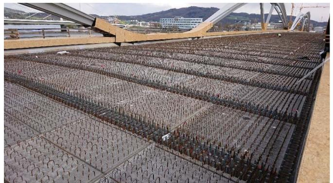
Abb. 6 Fahrbahnplatte nach dem FT-Verlegen
