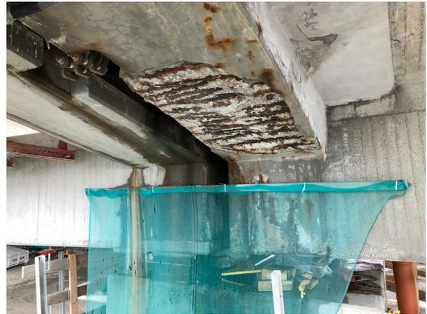
Abb.5 – Zustand Endquerträger, bestehende Betonsanierung
