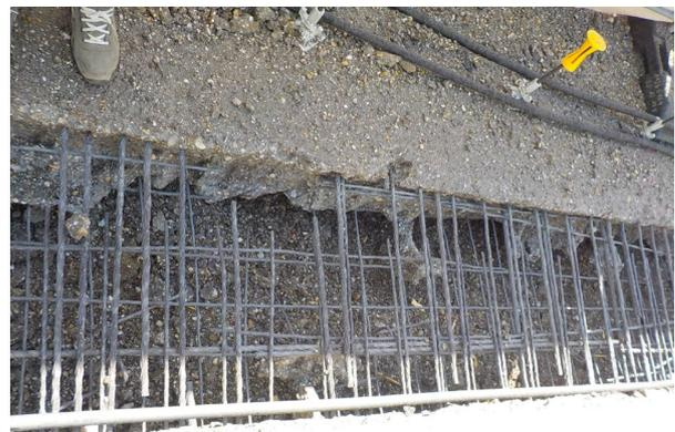
Abb.6 – Bestandsbewehrung nach HDW-Strahlen
