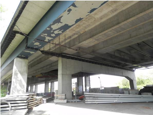
Abb.4 – Brückenverbreiterung mit Stahlverbundtragwerk
