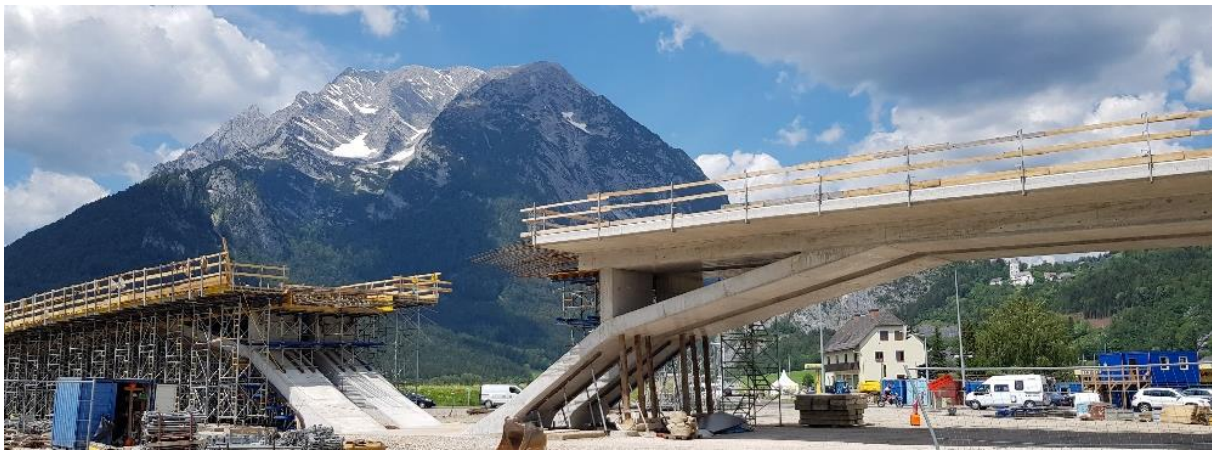
Abbildung 2: Integralbrücke Trautenfels vor Lückenschluss
