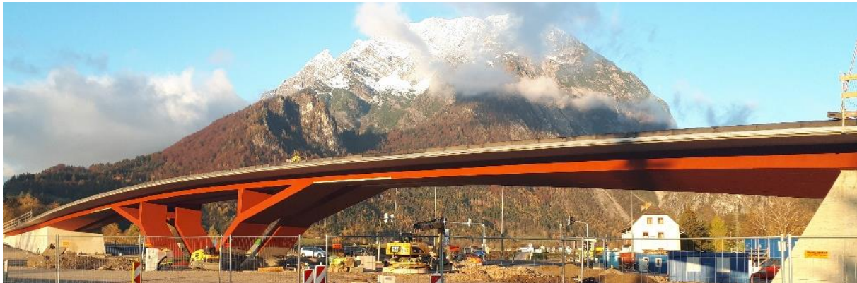
Abbildung 3: Integralbrücke Trautenfels ohne Brückenausrüstung
