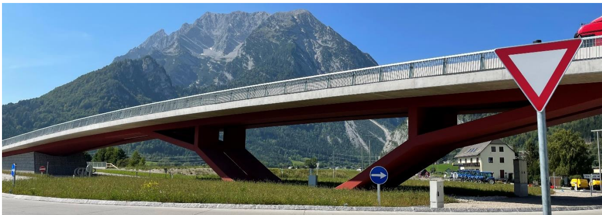
Abbildung 4: Integralbrücke Trautenfels nach Verkehrsfreigabe
