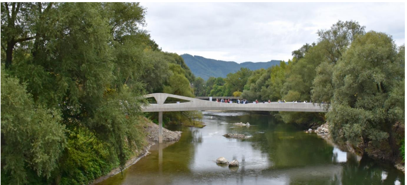
Abb. 5: Ansicht der Brücke von der bestehenden Nachbarbrücke aus (©Engelsmann Peters Beratende Ingenieure)
