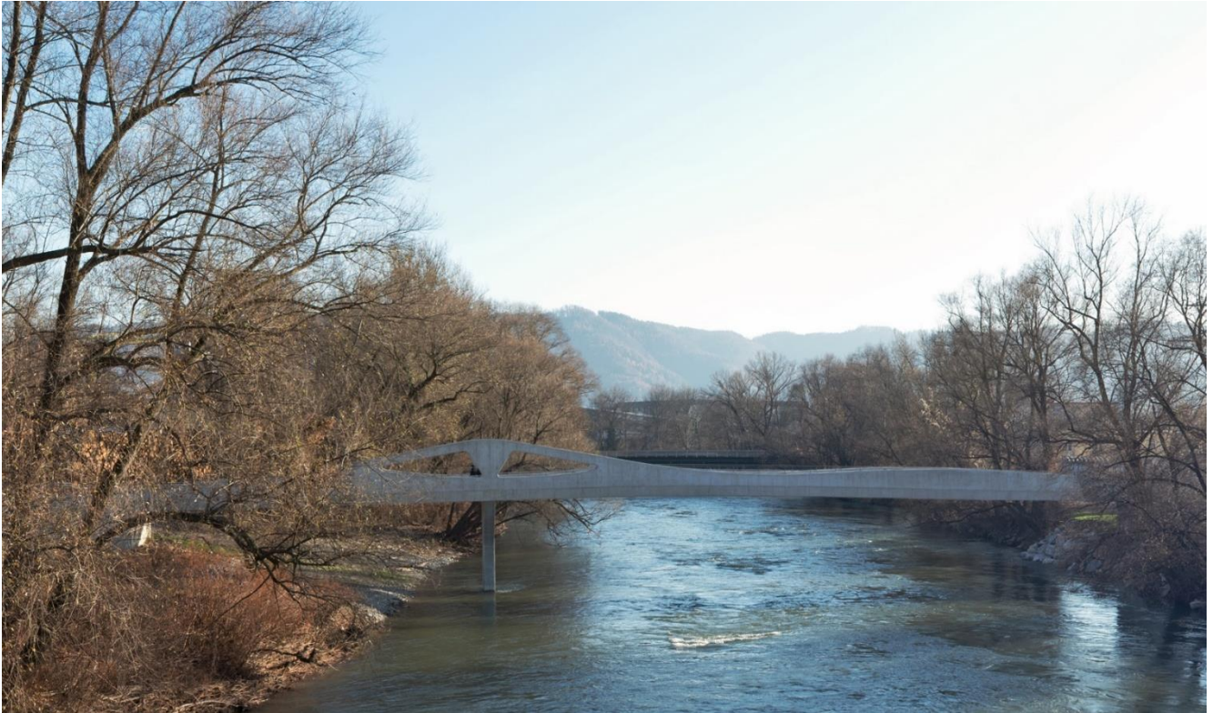
Abb.1: Ansicht der Geh- und Radwegbrücke von der bestehenden Nachbarbrücke aus (© Helmut Tezak)
