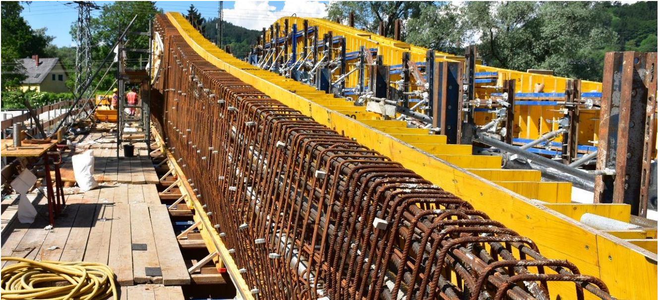
Abb.4: Schalung und Bewehrung des Brückenüberbaus (©Engelsmann Peters Beratende Ingenieure)
