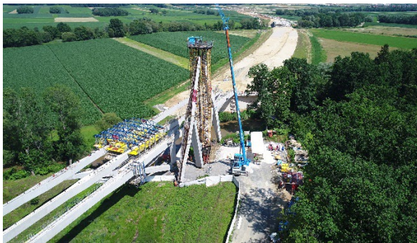
Bild 1: Herstellung der Brücke über die Lafnitz mit dem Brückenklappverfahren
