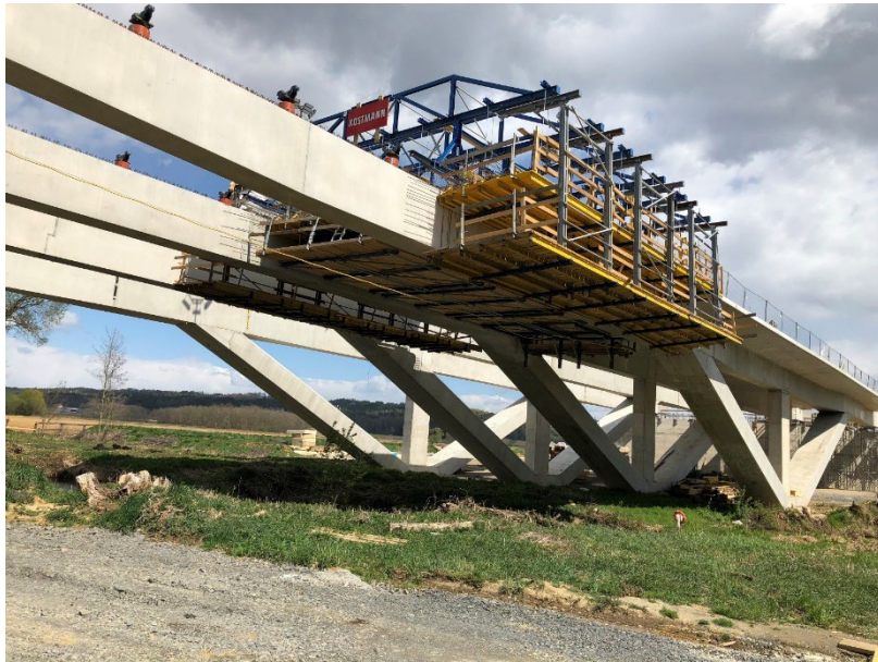
Bild 3: Herstellung der Fahrbahnplatte mit einem Verbundschalwagen bei der Brücke über den Lahnbach (S7)
