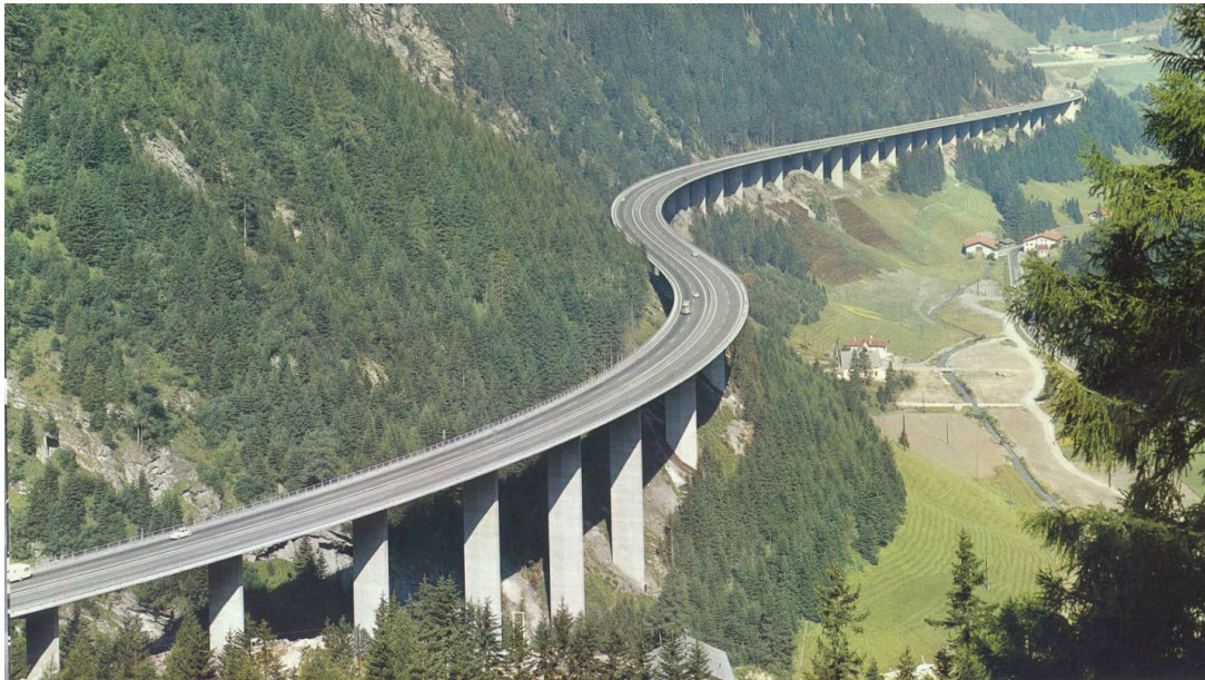
Bild 1: Luegbrücke auf der A13 Brenner Autobahn
