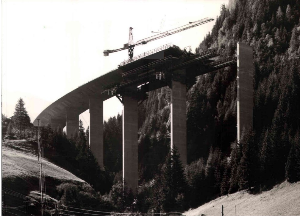
Bild 2: Herstellung Spannbetontragwerk mit Vorschubgerüst
