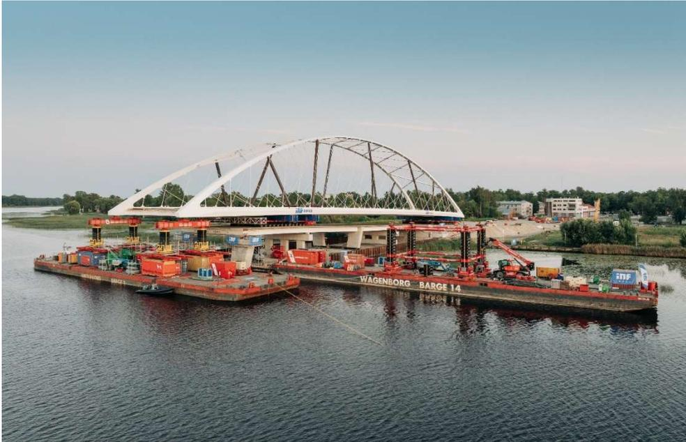
Abb. 3: Montage des Netzwerkbogens mit SPMTs und Pontons
