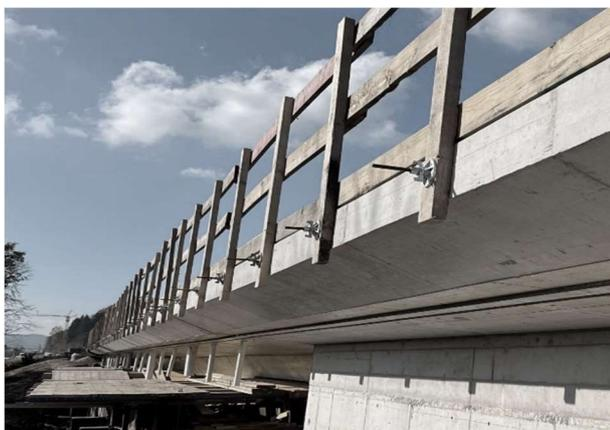
**Abbildung 6 Kragplatte mit innovativen Brückenrandsystem**
