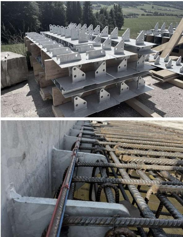
**Abbildung 8** Stahl-Verankerungssystem im angelieferten und eingebauten Zustand
