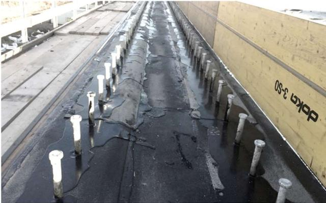
**Abbildung 2 Randbalkenverdübelung mit Dübelleisten – Ausführung Stand der Technik**
