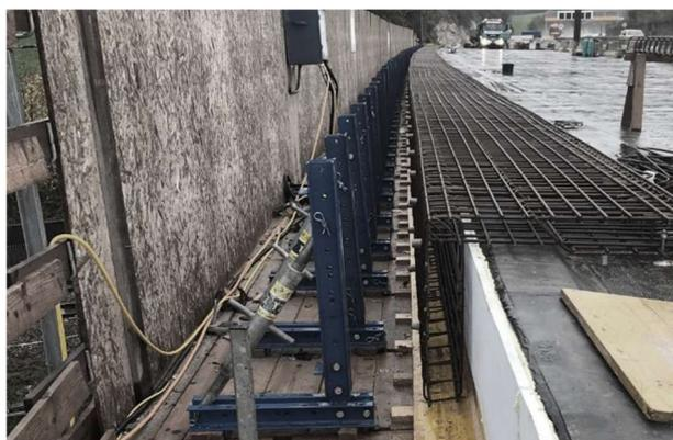
**Abbildung 1 Randbalkenherstellung - Ausführung Stand der Technik**
