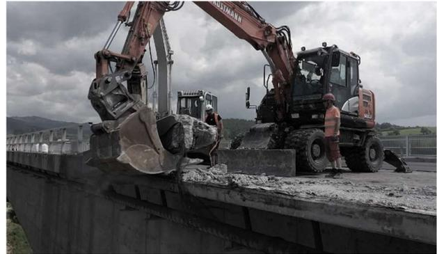
**Abbildung 4 Randbalkenrückbau**
