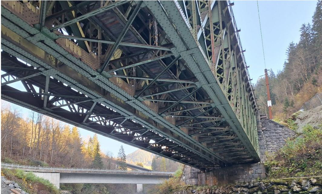
Abbildung 2: Fachwerkkonstruktion der Salzachbrücke Eschenau (Foto: ÖBB)
