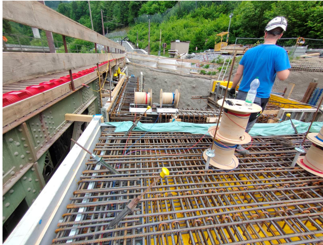
Sensoreinbau Tragwerk
