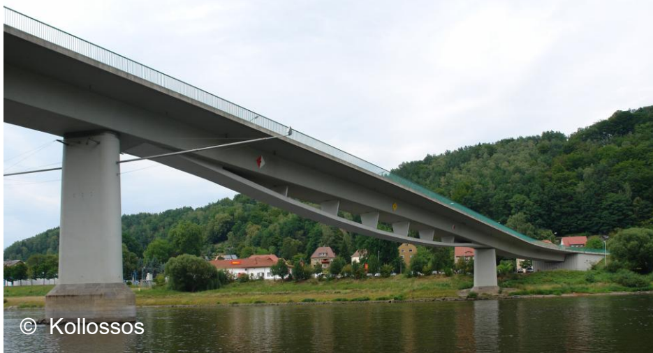
Elbbrücke Bad Schandau (1977) – wieder geöffnet für <7,5 Tonnen
