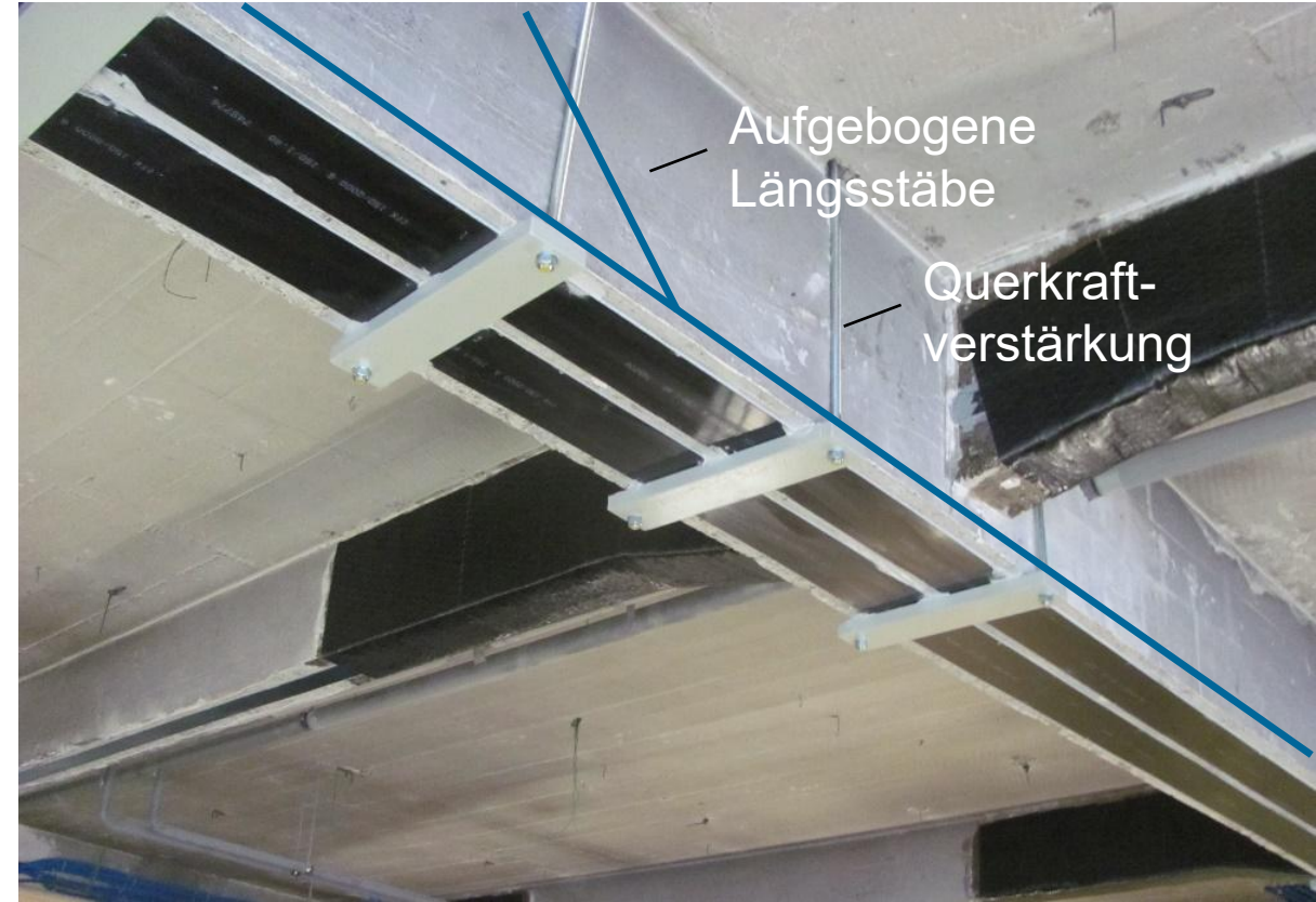
Stahlbetonbauteile mit aufgebogenen Längsstäben
