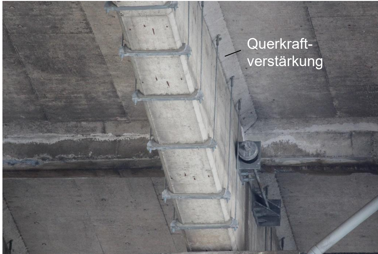
Spannbetonbauteile mit geringer Querkraftbewehrung
