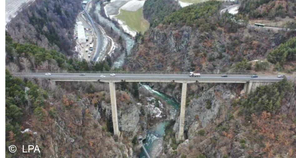
Riggertalbrücke (197x) – wird verstärkt, eingeschränkter Betrieb
